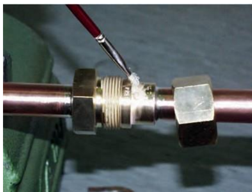
9. Смазать соответствующими смазочными материалами
